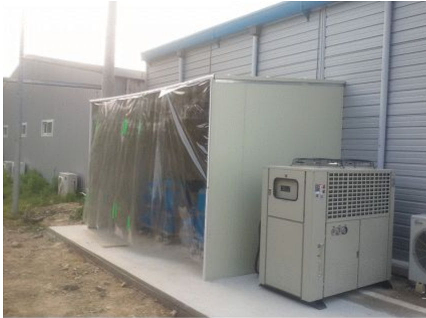
<그림 3.2.140 대용량 칠러 및 펌프 차양 설치>
