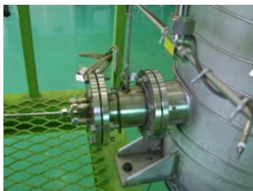
<그림 2.6-7 분무노즐 설치>
