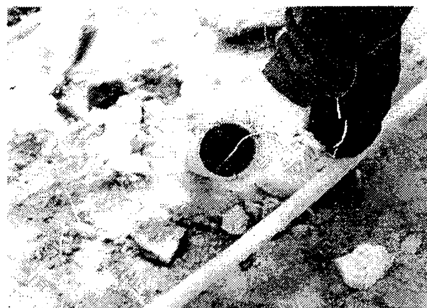
Fig. 3.6.2.3 폭약 장착 및 튜브 변형 방지를 위한 보조 도구
