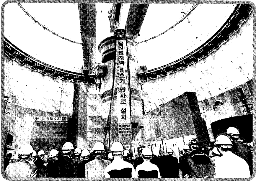
▶ 울진 원자력 5호기 원자로 설치 (2001. 6. 21)
