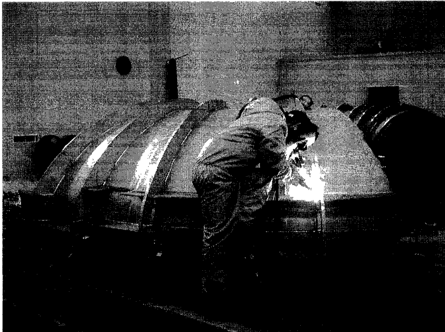
그림 3.2-131 Back & cooling chamber 용접
