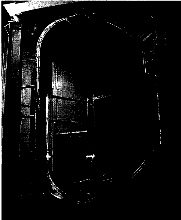
그림 3.2-140 Test flange 용접
