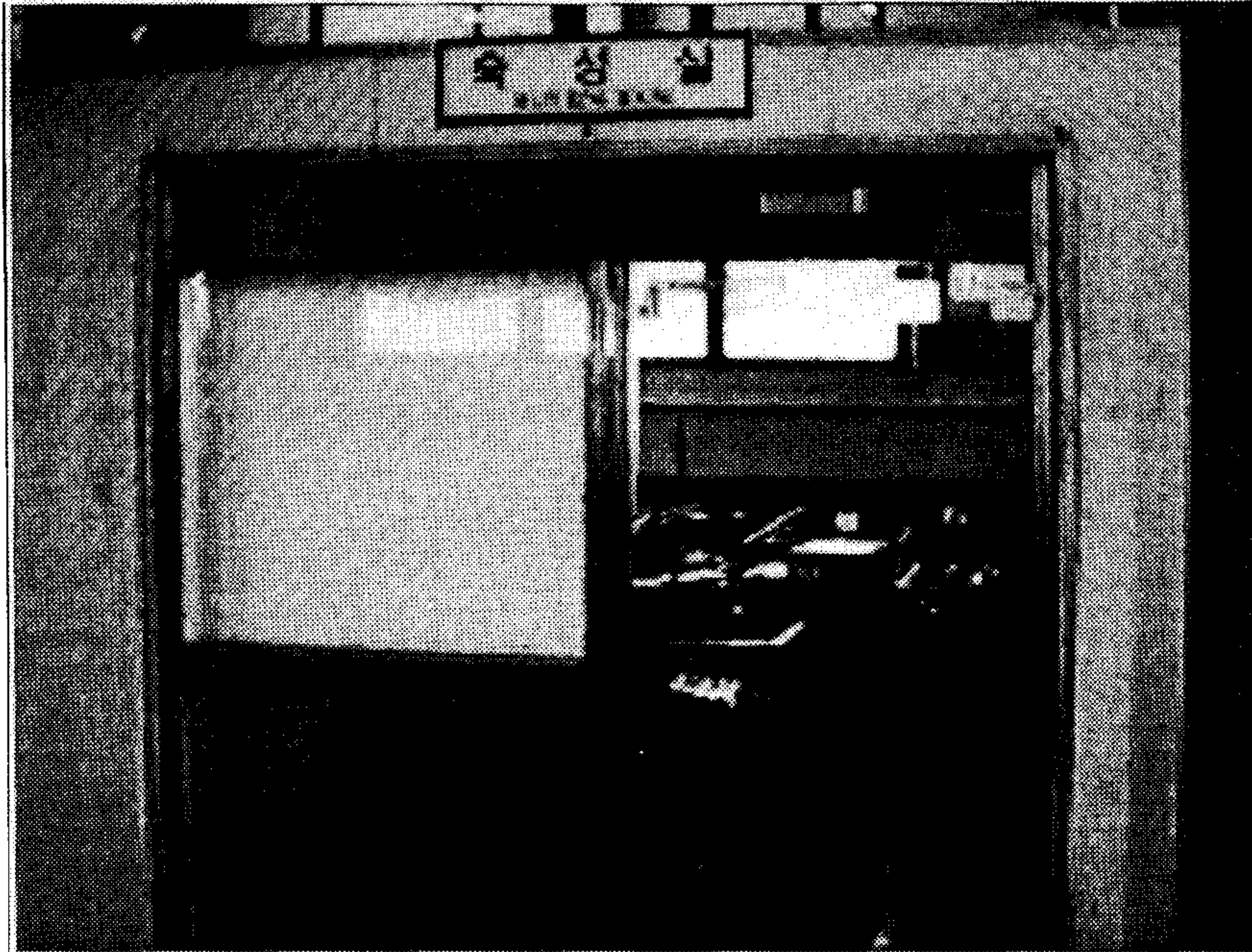
사진3-1 설치된 숙성실 오출고 자동차단문
