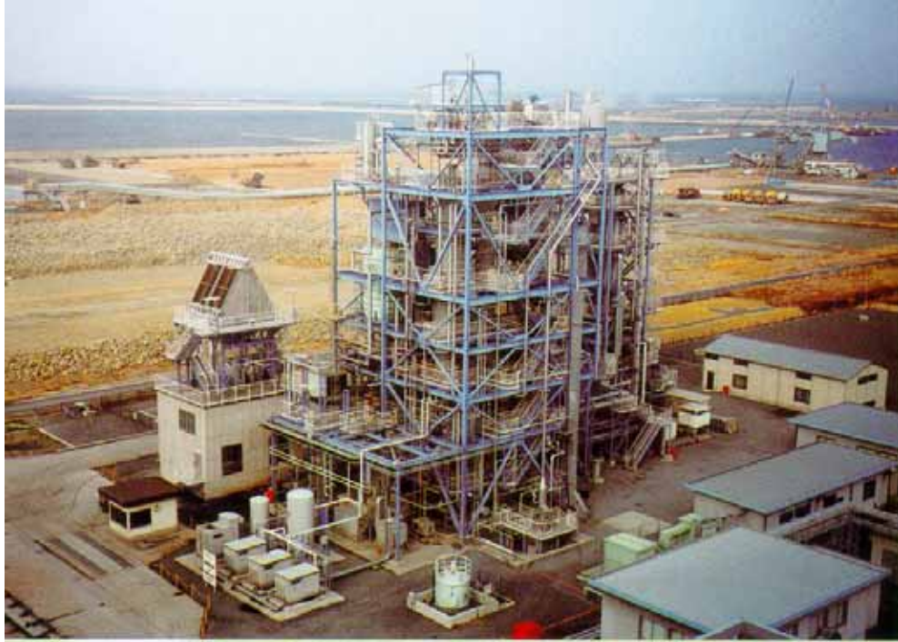
〈그림 117〉 일본 전원개발(주)에서 개발한 0.6MW급 RDF화력 발전 파일럿시스템
