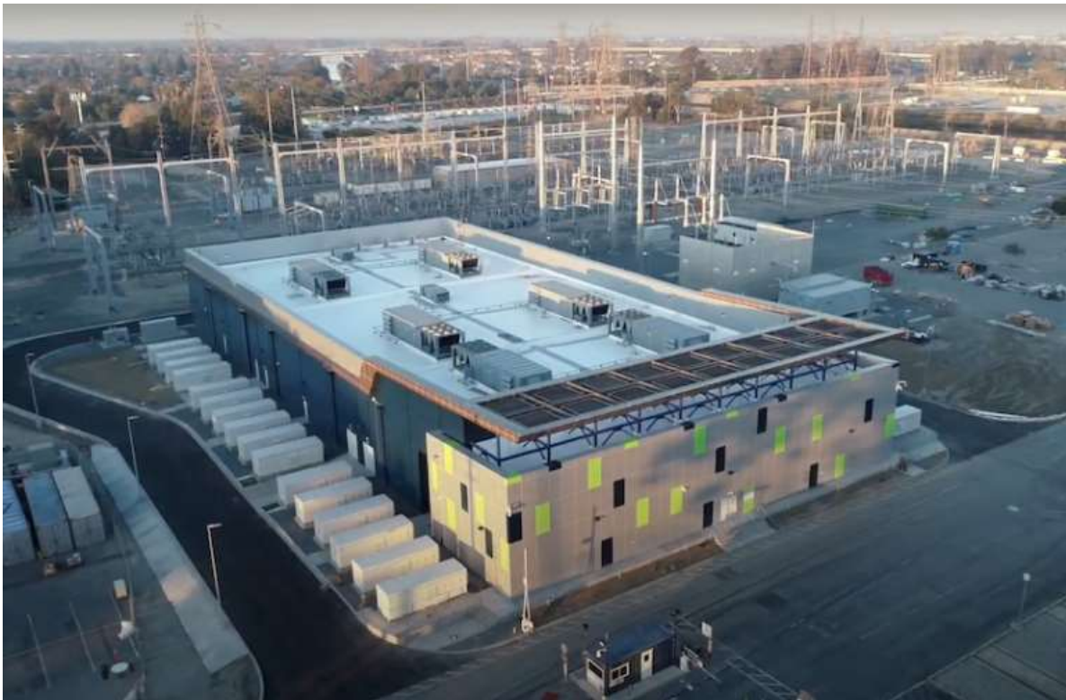
[그림 2-29] 400MWh의 Alamosa BESS 프로젝트(캘리포니아)
