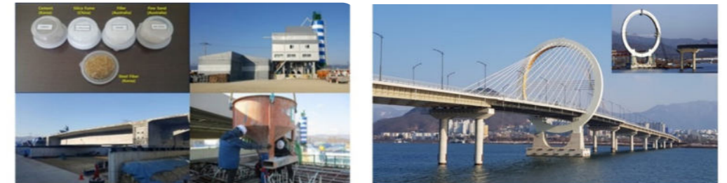
[슈퍼콘크리트의 춘천대교 현장 적용]
