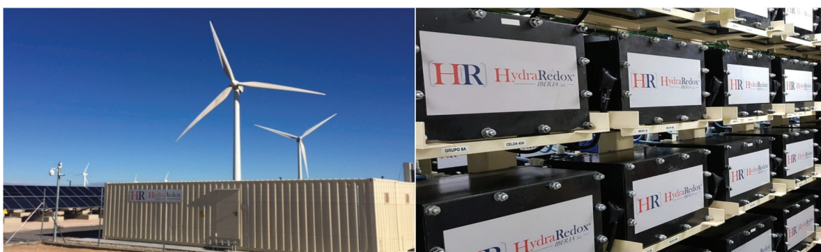
<그림 2> HydraRedox - Installation off-grid/- Energy storage installation
